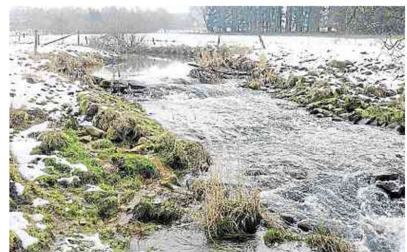
An der oberen Nister werden strukturverbessernde Maßnahmen durchgeführt. Ziel ist es, die Durchgängigkeit von Querbauwerken, wie hier bei einem alten Wehr, zu erzielen.
